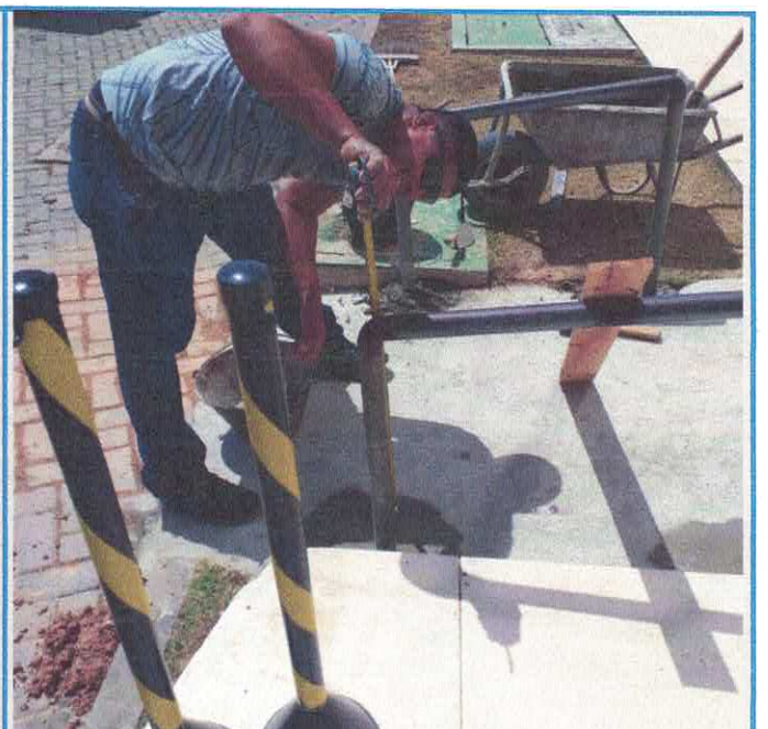
Obra: HOSPITAL DA MULHER DO RECIFE Legenda: Implantação de alça de apoio para rampa de acessibilidade Data da foto retirada: 07/02/2020
